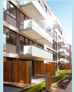
Neubau »HalbeHalbe« in Eilbek
